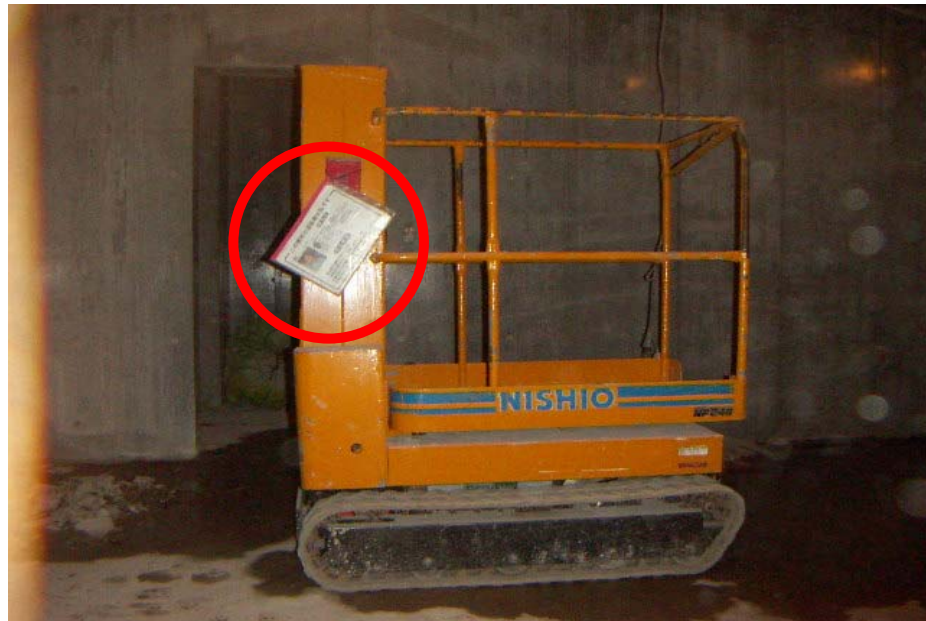
高所作業車に使用する運転者の資格パネルを掲げている
