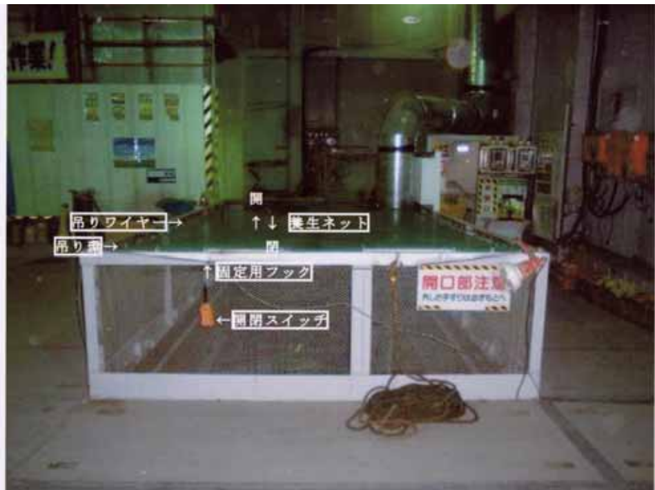
写真 1 立坑養生ネット開閉装置設置状況
