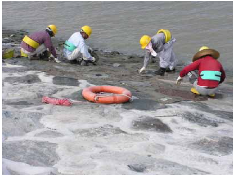
傾斜護岸部でのスキベルト使用状況
