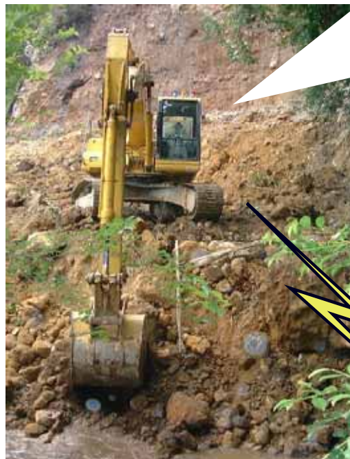
ロボQによる土砂崩れの緊急災害復旧作業
